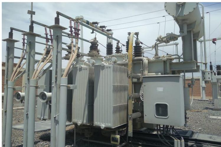
Figura 2. Transformador de Potencia
